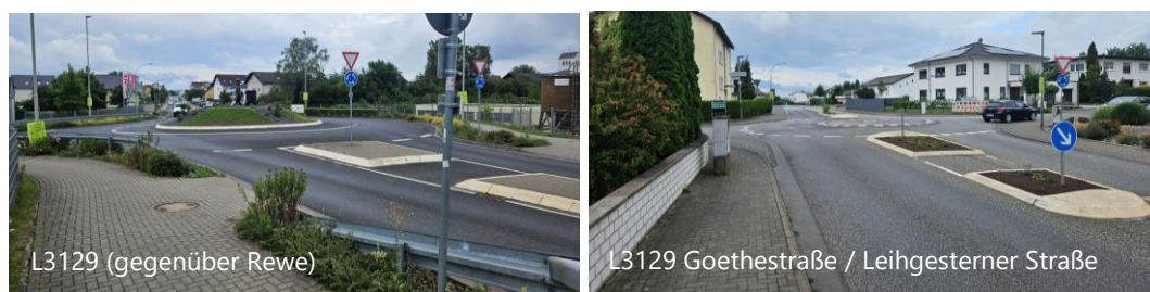
Abbildung 70: Querungsstellen entlang des Haupt-Fußverkehrsnetzes (Hauptschulwege) ohne gesicherten Vorrang für den Fußverkehr
