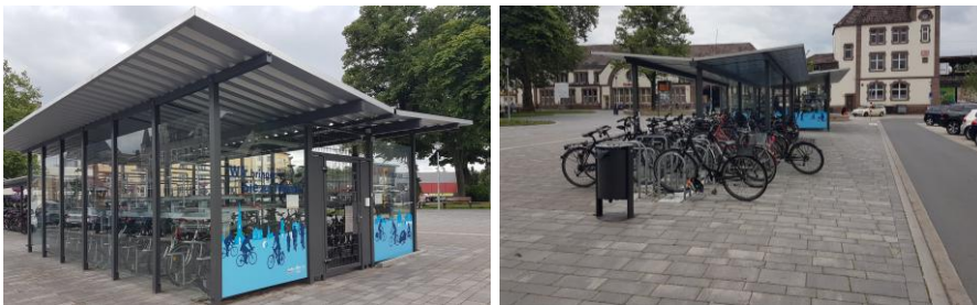
Abbildung 60: Good-Practice Fahrradabstellanlage am Schwerter Bahnhof
