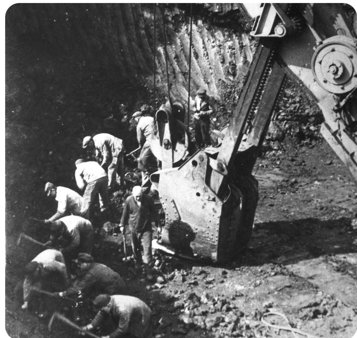
(5) Elektrobagger mit Löffel im Einsatz (umrüstbar auf Schürfkübel) 1952.
