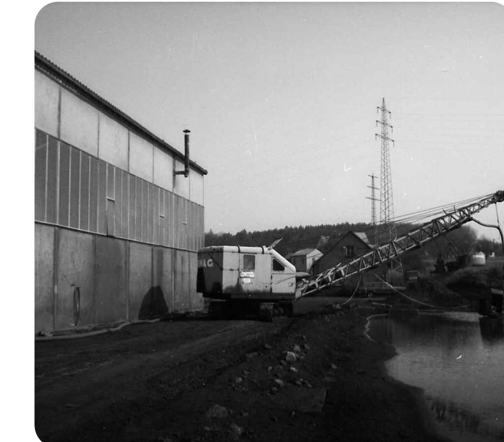
(8) Filterpressenhalle 1967; ein Bagger mit Saugpumpe fördert Schlämme aus dem Flotationsbecken zur Presse.
