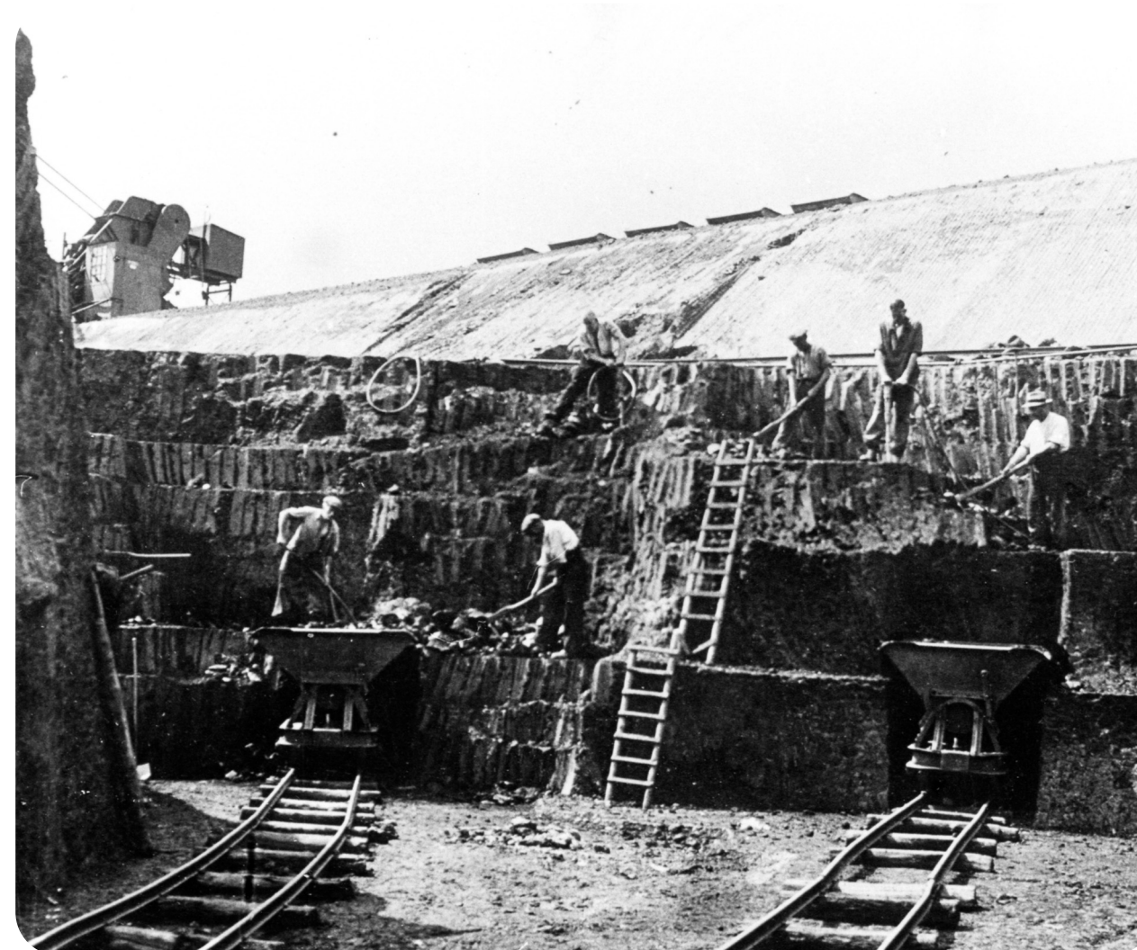
(4) Abbau auf "Strossen" (Stufen) mit Pressluftspaten 1938; oben links: Eimerkettenbagger räumt Abraum.
