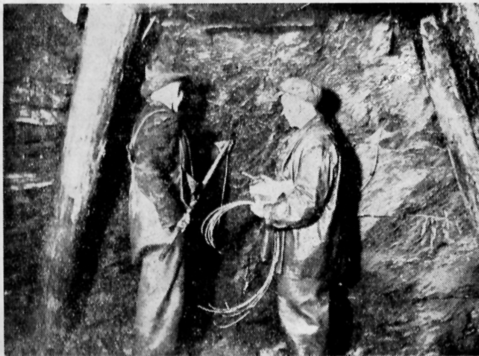
Sprengpatronen werden in vorgebohrte Löcher eingeführt.
