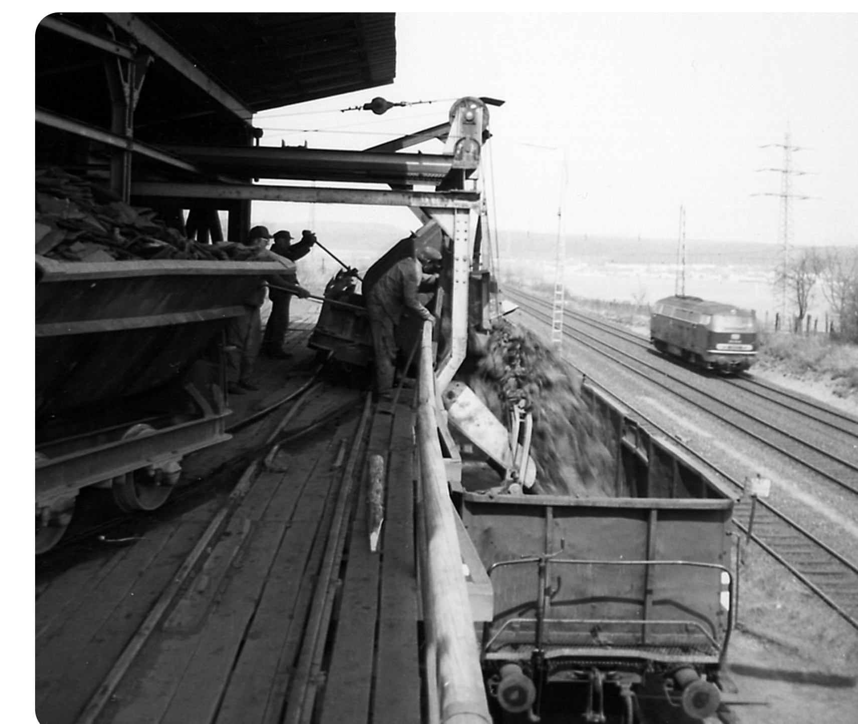
(5) Mit einer Kippvorrichtung der Verloaderampe wird das Farberz in einen DB Waggon abgekippt, 1976.
