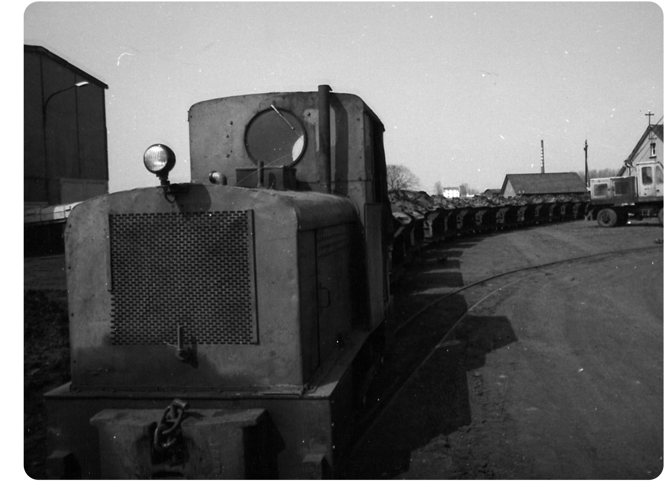
(6) Ein Zug der Feldbahn 1976 am Zechenhaus (heute Grillgebäude); die Kippwagen wurden über ein Förderband aus der Filterpressenhalle heraus (links) beladen. Die Filterpresse wurde ab 1967 zur Trocknung von Farberz eingesetzt.
