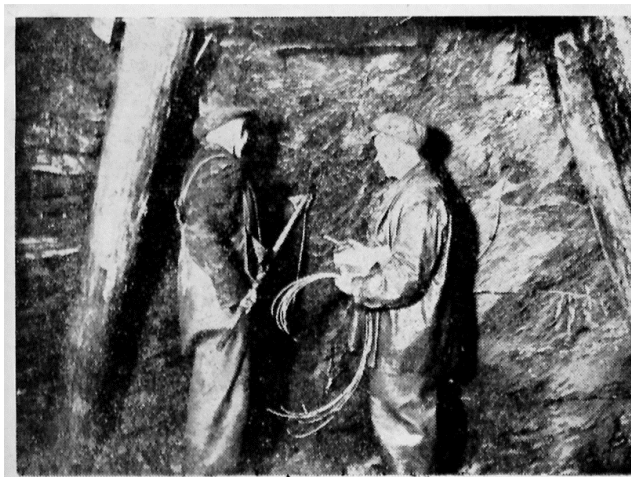
Sprengpatronen werden in vorgebohrte Löcher eingeführt.
